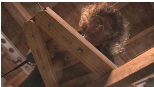
In die Verstärkung Platz für den Querbalken aussägen.
